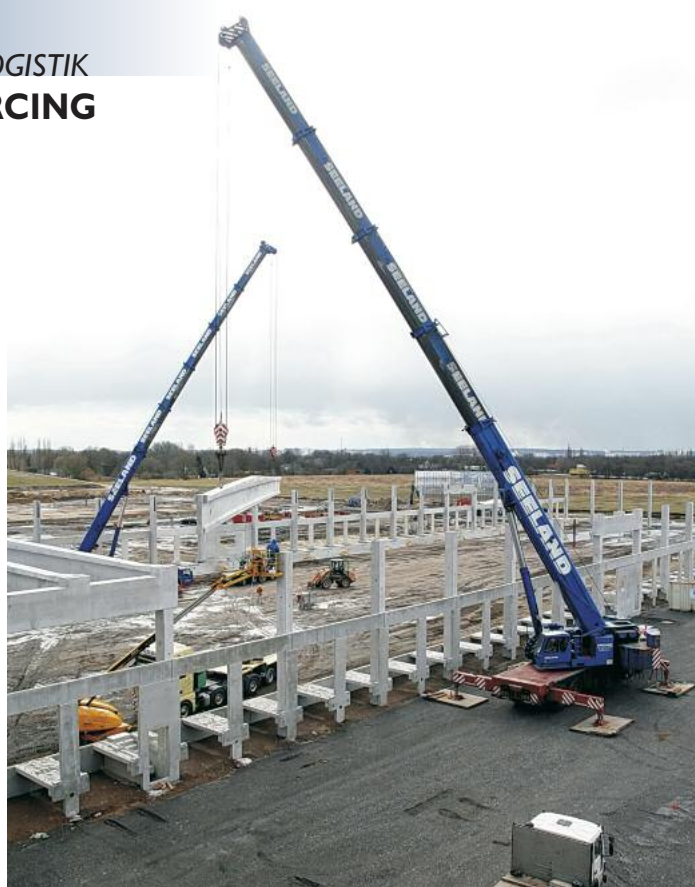
Mit Gefühl: Zwei Schwerlastkrane haben einen 50 m langen und 65 t schweren Betonbinder aufgenommen. Minuten später hat er sein Ziel erreicht. Präzisionsarbeit ist hier erforderlich
