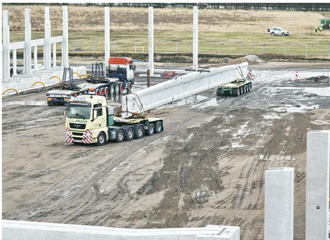
Spielzeuglandschaft: Von „Legobauen in groß“ sprechen die Ingenieure, wenn gewaltige Fertigbetonteile angeliefert und verbaut werden. Jeder Tag bringt neue Baufortschritte
