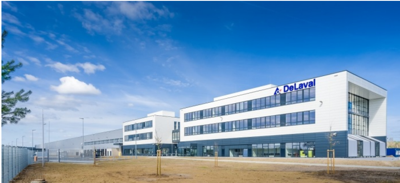
Bildunterschrift: Verdion_DeLaval Bürogebäude
