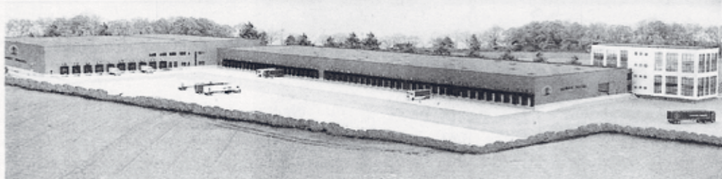
Bau beantragt: Das geplante Logistikzentrum von Kühne & Nagel an der Ludwig-Erhard-Allee. Das südlich gelegene Regallager (links, 12 Meter hoch) liegt im Gewerbegebiet und hält Lärm vom Hof ab. In der Mitte die Umschlaghalle, rechts die Verwaltung. Lastwagen warten auf dem Gelände. COMPUTERGRAFIK: YUHA
